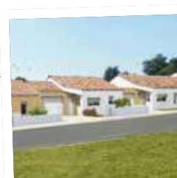
Val du Bourgneuf 4 logements livraison été 2017 contact : 02 51 45 23 04
